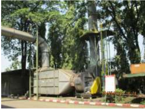
ภาพที่ 2.48 ระบบบำบัดมลพิษทางอากาศ (Scrubber) และพัดลมระบายอากาศภายใน โรงจัดเก็บ Solid Waste
