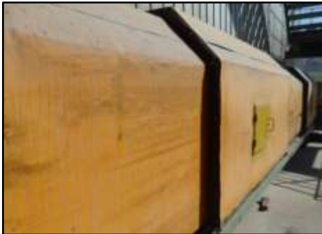
ภาพที่ 3.102 อาคารปิดคลุมเพื่อป้องกันเสียงออกสู่ภายนอกบริเวณอาคารหม้ออบดซีเมนต์และติดตั้งวัสดุ ป้องกัน/ลดระดับเสียงดัง Casing ทุ้มชุด Hammering Equipment
