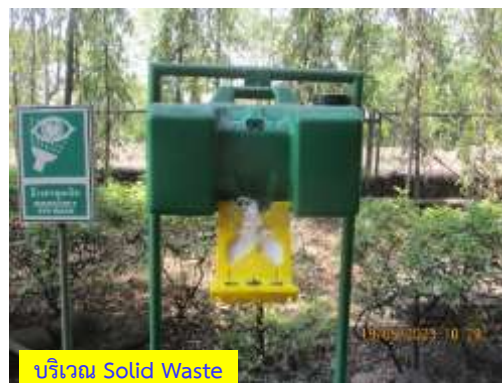
ภาพที่ 2.51 ฝักบัวฉุกเฉินและอ่างล้างตาฉุกเฉินภายในพื้นที่โครงการ
