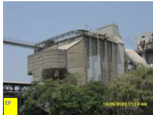
ภาพที่ 2.3 อุปกรณ์บำบัดฝุ่นชนิดถุงกรอง (BF) และระบบไฟฟ้าสถิตย์ (EP)
