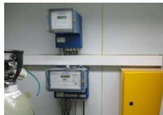
ภาพที่ 2.6 ห้องควบคุมและอุปกรณ์ตรวจวัดก๊าซประจำหม้อเผา
