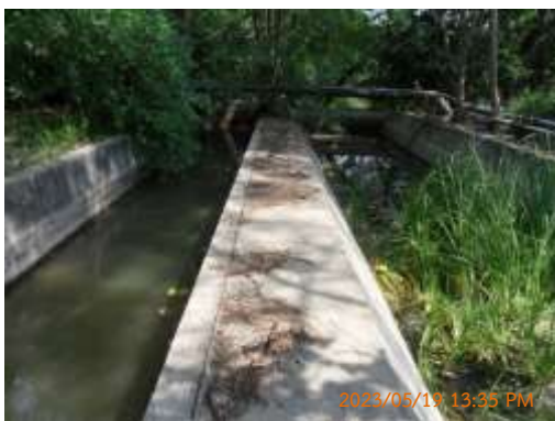
ภาพที่ 2.13 บ่อดักไขมันก่อนที่จะไหลลงสู่บ่อดักตะกอน
