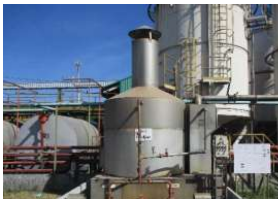
ภาพที่ 2.7 ระบบบำบัดไอสารอินทรีย์โดยใช้ Bio Filter สำหรับถังเก็บ Liquid Waste
