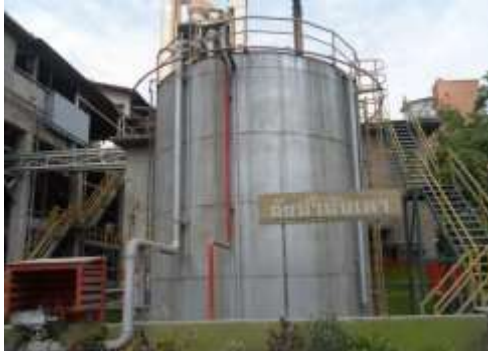
ภาพที่ 1.11 สภาพถังเก็บน้ำมันเตาและถังเก็บน้ำมัน Day Tank
