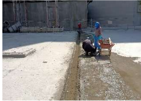
ภาพที่ 2.14 การล้างท่อและวางระบายน้ำในพื้นที่รอบๆ โครงการ
